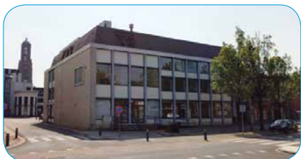
Voormalig pand 'Collegeveste'.
